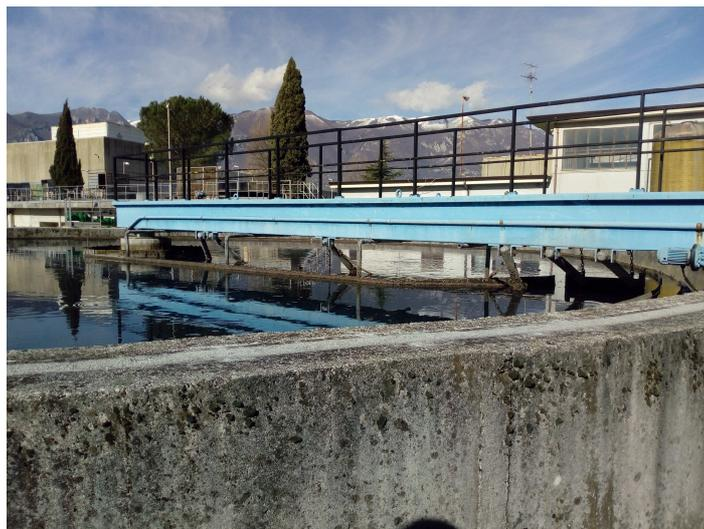
Figura 4.9 - Carroponete di una vasca di sedimentazione primaria
