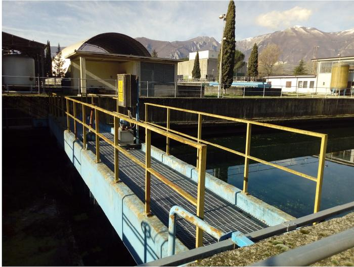
Figura 4.4 - Carroponte e quadro elettrico della vasca a pioggia
