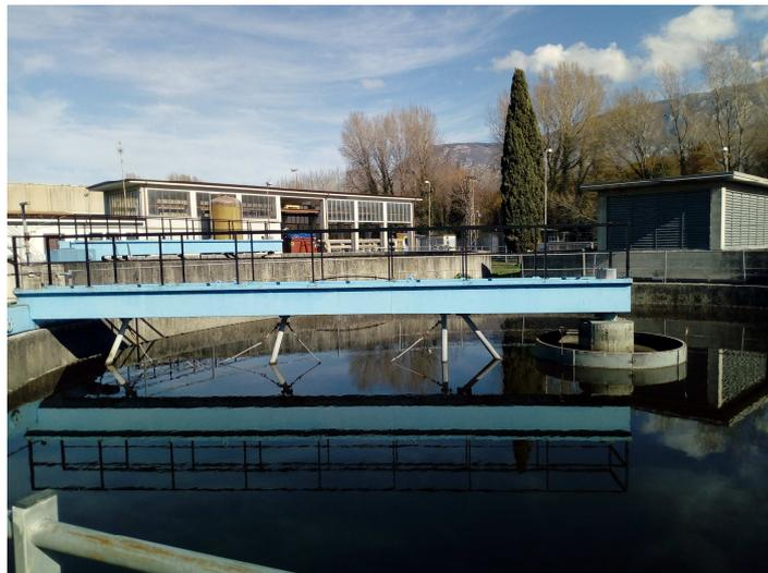
Figura 4.12 - Carro ponte di una vasca di sedimentazione secondaria
